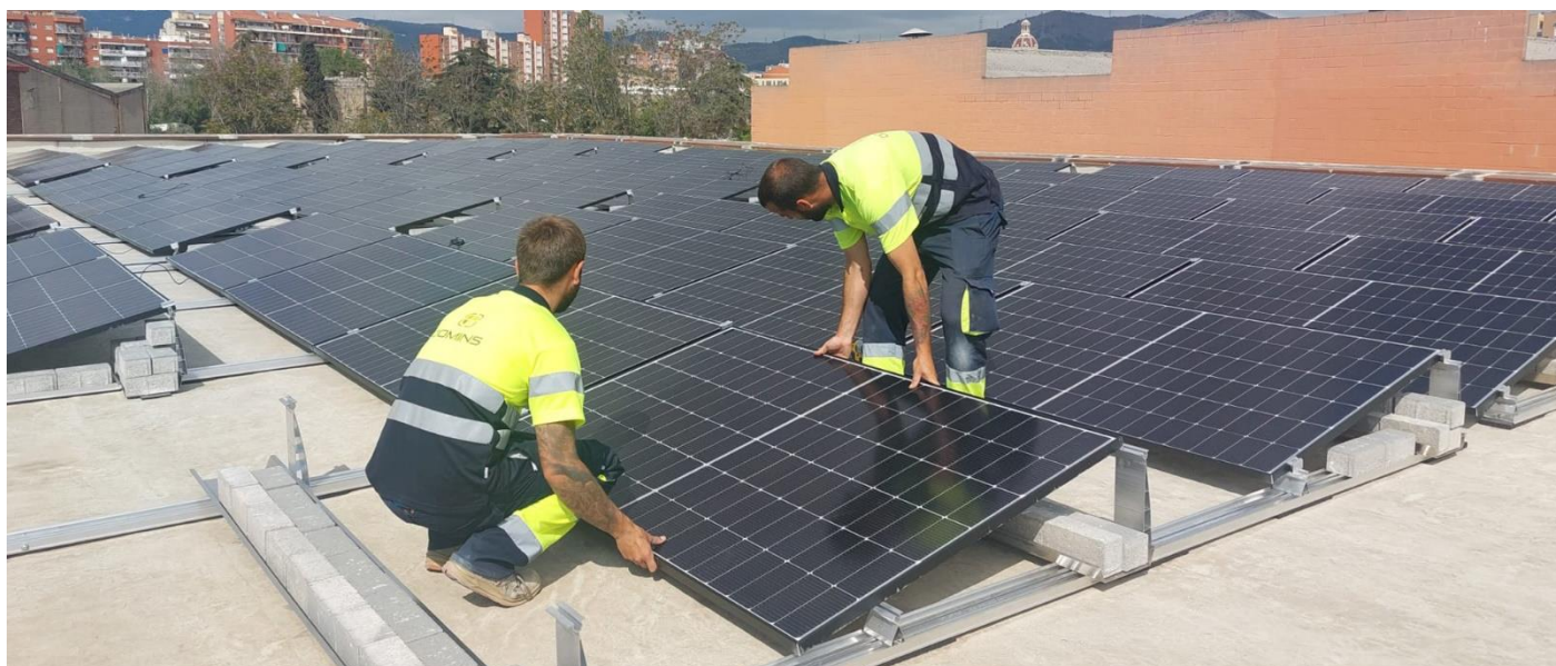
Obres d'ampliació de la planta de producció d'energia solar de Femarec.
